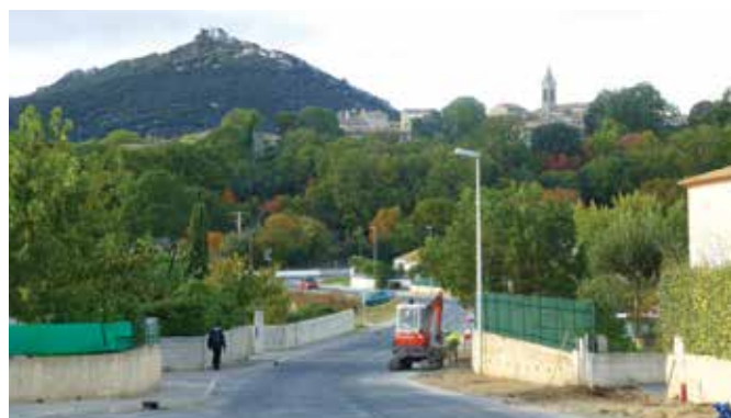
Création d'une piste cyclable - Avenue des Côteaux de Montferrand
