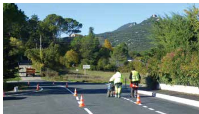
Pose du marquage au sol - Rue des Écoles
